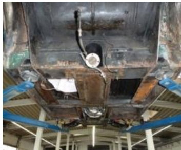
Offener Unterboden, Oberflächenrost auf Träger wird entfernt
